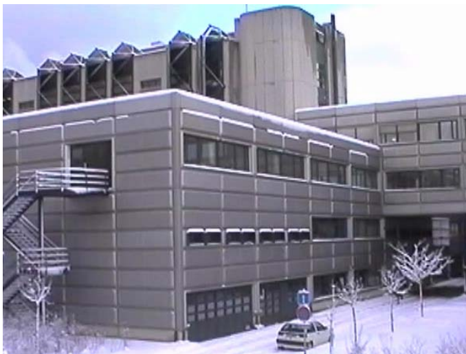
Bâtiment de Chimie - Halles
